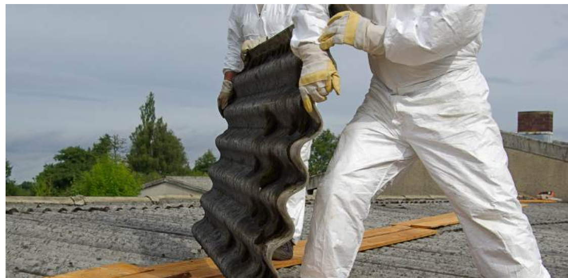
De openbare gebouwen werden asbestvrij gemaakt en burgers krijgen hulp bij het afvoeren van hun asbestafval.
